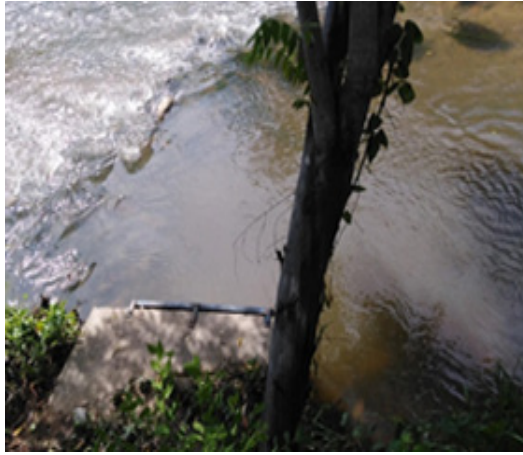
Fotografía 18. Bocatoma del río Ranchería. En la actualidad, capta 3 litros por segundo, aproximadamente. Tomada por Liza Gaitán (2019).
